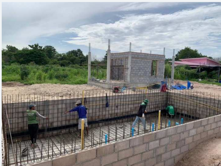
การจัดทำพื้นและปรับผิวคอนกรีต
