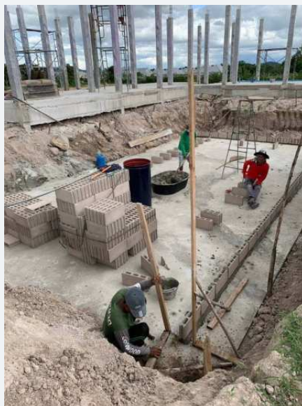
การก่อผนังและขึ้นรูปส่วนเปลือกอาคาร
