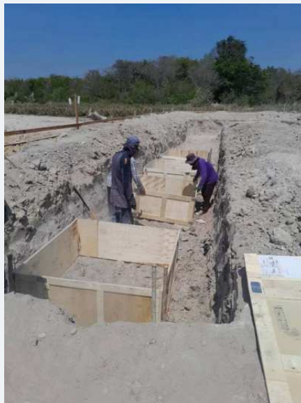
การขุดและเตรียมงานฐานรากในพื้นที่ก่อสร้าง
