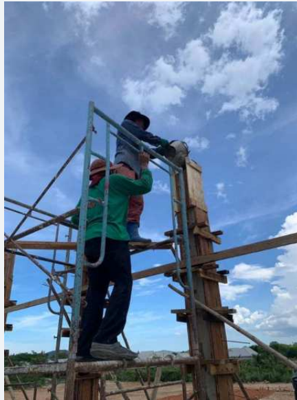
การเตรียมเสาและกิจกรรมงานโครงสร้าง
