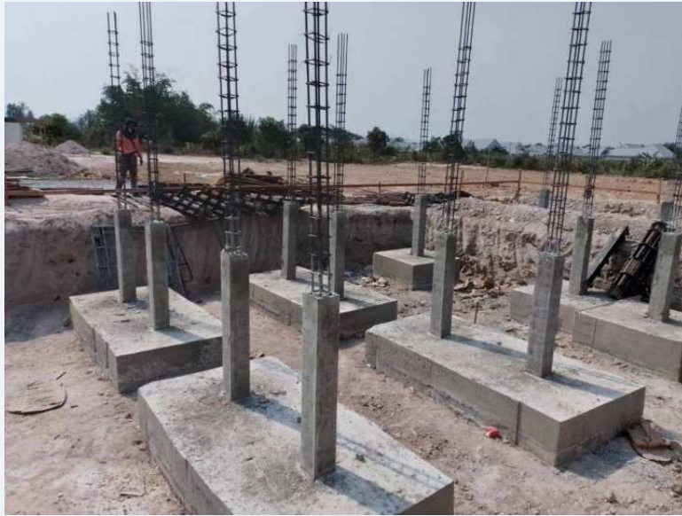
งานโครงสร้างอาคารระหว่างดำเนินการ
