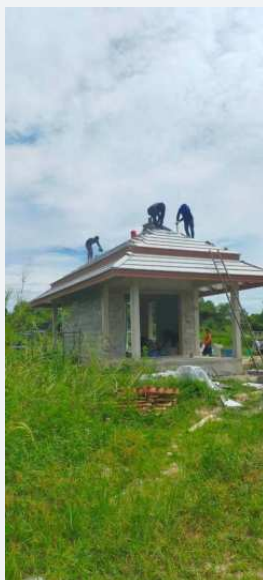
มุมมองความคืบหน้าของรูปทรงอาคาร
