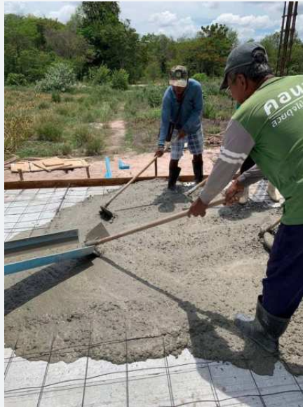
การดำเนินงานเทคอนกรีตในพื้นที่ก่อสร้าง
