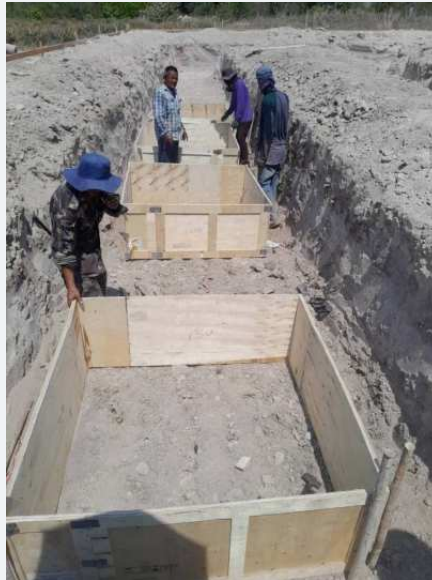
การเตรียมพื้นที่บริเวณฐานรองรับโครงสร้าง
