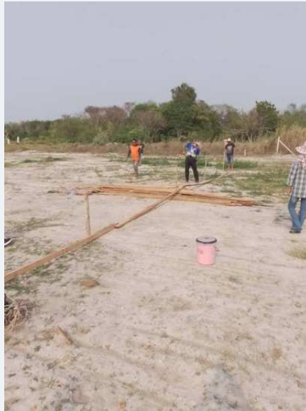
ภาพการกำหนดแนวและเตรียมพื้นที่ผิวน้ำงาน
