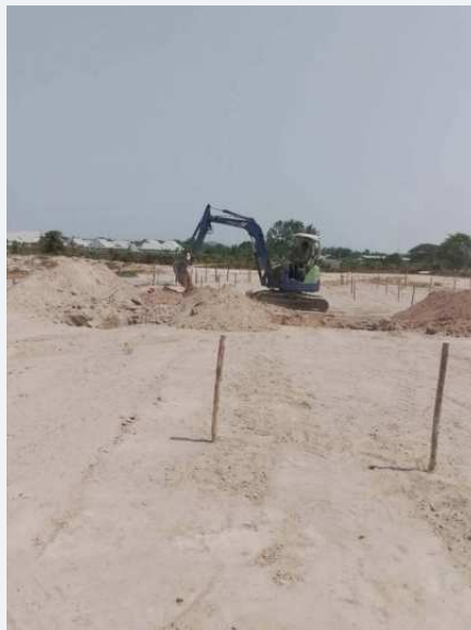
การดำเนินงานดินและเตรียมบริเวณก่อสร้าง
