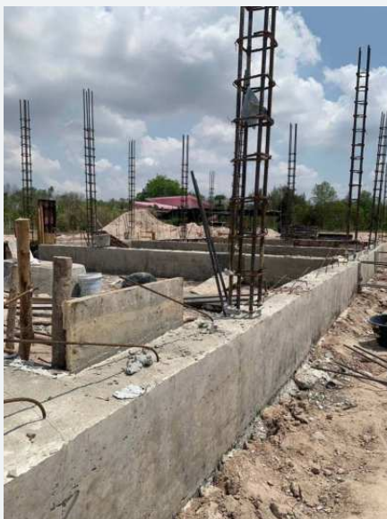
งานเหล็กเสริมก่อนขั้นตอนคอนกรีตที่เกี่ยวข้อง
