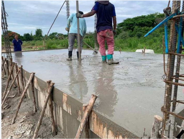
ภาพขั้นตอนงานคอนกรีตเสริมเหล็ก
