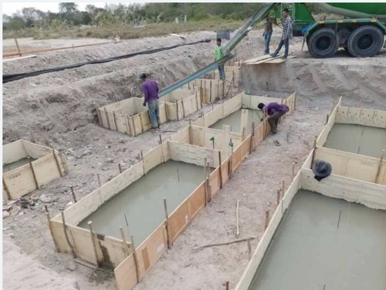
การขุดและเตรียมงานฐานรากในพื้นที่ก่อสร้าง
