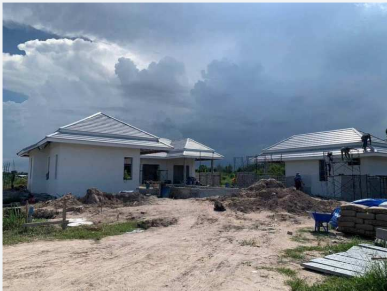
ภาพรวมอาคารในช่วงดำเนินการก่อสร้าง
