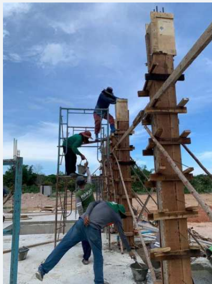
งานโครงสร้างอาคารระหว่างดำเนินการ
