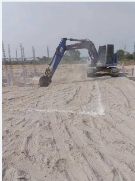
ภาพการปรับระดับและเตรียมพื้นที่ก่อนเริ่มงาน
