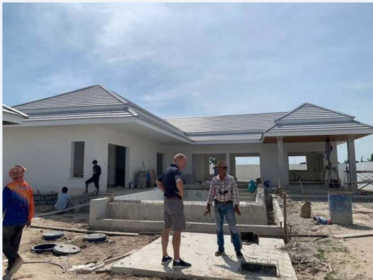
มุมมองความคืบหน้าของรูปทรงอาคาร
