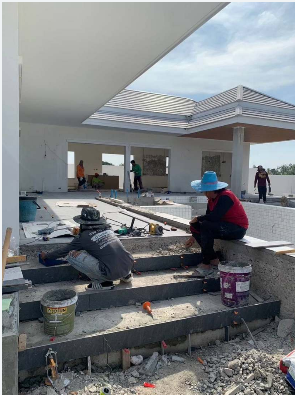
ภาพรวมอาคารในช่วงดำเนินการก่อสร้าง
