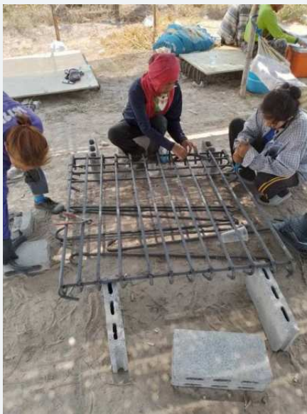
การจัดวางเหล็กเสริมสำหรับองค์ประกอบอาคาร
